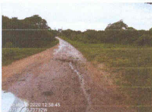
Vista do trecho -2.997099, -39.737323
