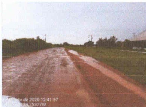
Vista do trecho -3.024909, -39.753765
