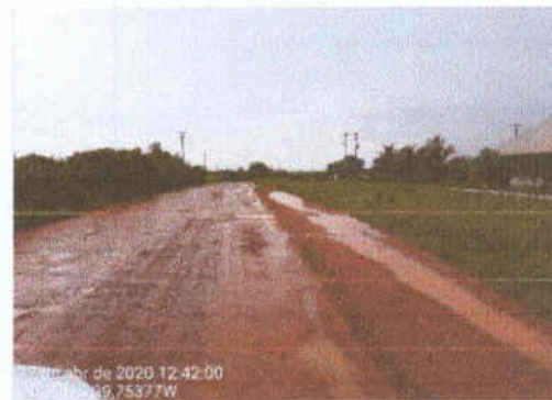
Vista do trecho -3.024909, -39.753765
